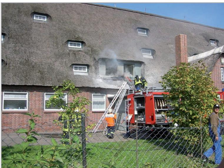
Abbildung 19 - Brandherd unterhalb einer Gaube in der Hinterlüftungsebene
