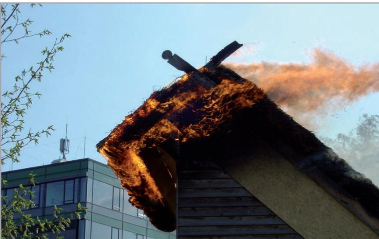
Abbildung 16 - Feuer breitet sich unterhalb der Traufe in der Hinterlüftung aus (Löscherfolg nicht mehr gegeben!)
