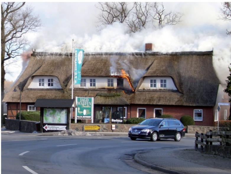
Abbildung 24 - Brand breitet sich durch offenes Fenster in Hinterlüftungsebene und auf dem Reet aus. Aufgrund großflächiger Rauchentwicklung im First ist nicht mehr mit einem Löscherfolg zu rechnen!
