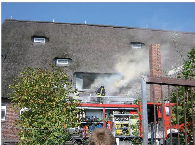
Abbildung 20 - Trotz Löschmaßnahmen breitet sich das Feuer weiter aus (vermehrte Rauchentwicklung), da keine Öffnung der Eindeckung um den Brandherd stattfand
