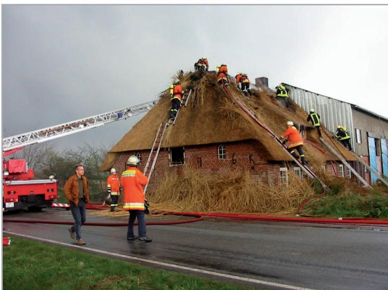
Abbildung 11 - Entfernen des Reet im betroffenen Firstbereich
