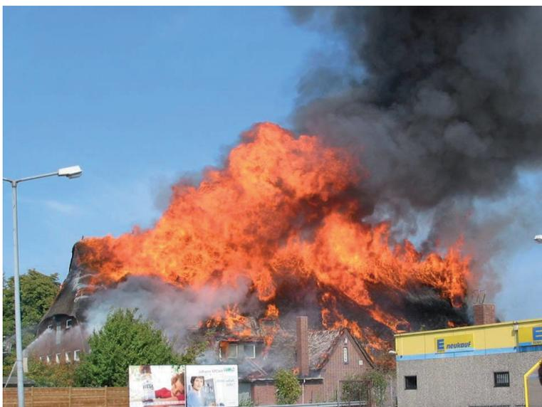
Abbildung 23 - Schnelle und großflächige Durchzündung des Daches
